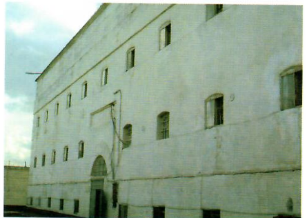
Старый корпус СИЗО-2 постройки 1851 года
